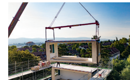
ABB. 3-5 Flexibles Modulsystem: Aufstockung des zwanzigjährigen Pavillons Friesenberg im Sommer 2019.
