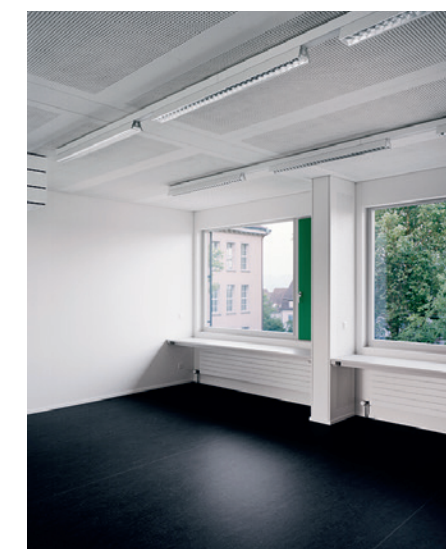
ABB. 7 Bis auf Bodenbelag, Anstrich und Möblierung sind die Module im Werk vorgefertigt.
