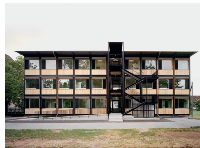
ABB. 1 Züri-Modular-Pavillon, 2. Generation, seit 2012. Die zweite Generation bietet zehn Prozent mehr Fläche und entspricht Minergie-Eco. Die Module der zweiten Generation können um bis zu drei Geschosse aufgestockt werden.
