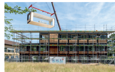
ABB. 3-5 Flexibles Modulsystem: Aufstockung des zwanzigjährigen Pavillons Friesenberg im Sommer 2019.
