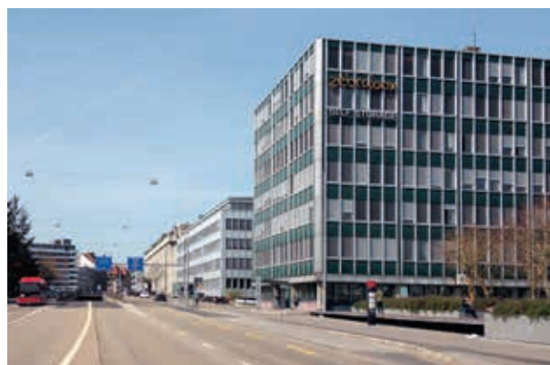
Vor dem Umbau: Die Bestandsfassade folgte einem vertikalen Raster .
