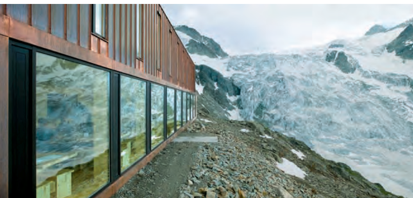
^8_L'annexe de la cabane CAS de Moiry est, sous la façade en cuivre, un ouvrage en éléments préfabriqués en bois. Photos: Thomas Jantscher
