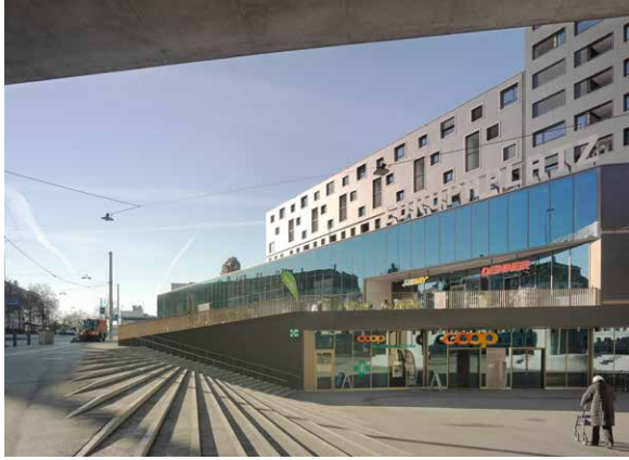
Grosszügige Stufen überbrücken den Höhenunterschied und dienen als Sitzgelegenheit.
