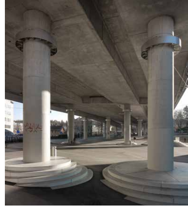
Die neuen Stufen der Pfeiler laden ebenfalls zum Verweilen ein.
