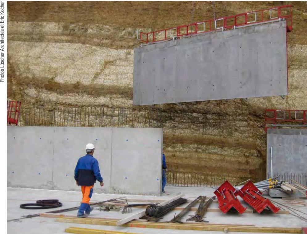
Mise en place des banches métalliques de coffrage.
