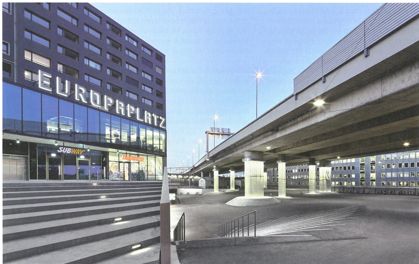
1 Das Zentrum Europaplatz (l.) in Ausserholligen und der neugestaltete Platz unter der Autobahnbrücke der A12, 2015.
