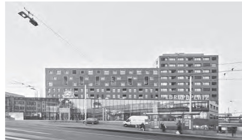
LE SOCLE VITRÉ DU BÂTIMENT ABRITE LA MAISON DES RELIGIONS. IL S'AGIT D'UNE «MAISON OUVERTE» QUI DONNE ACCÈS À TOUS LES INTÉRESSÉS. EN MÊME TEMPS ELLE LES ABRITE EN LES PROTÉGÉANT DES REGARDS PAR TROP INDISCRETS | IM GLÄSERNEN SOCKELBAU DES GEBÄUDES BEFINDET SICH DAS HAUS DER RELIGIONEN. ES IST EIN OFFENES HAUS, IN DAS DIE GEMEINSCHAFTEN ALLE INTERESSIERTEN EINLADEN - GLEICHZEITIG BIET ES IHNEN SCHUTZ VOR ALLZU NEUGIERIGEN BLICKEN
