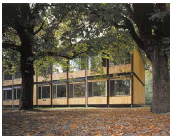
PAVILLON SCOLAIRE ZÜRI-MODULAR | ZÜRI-MODULAR SCHULHAUS © RUEDI WALTI
