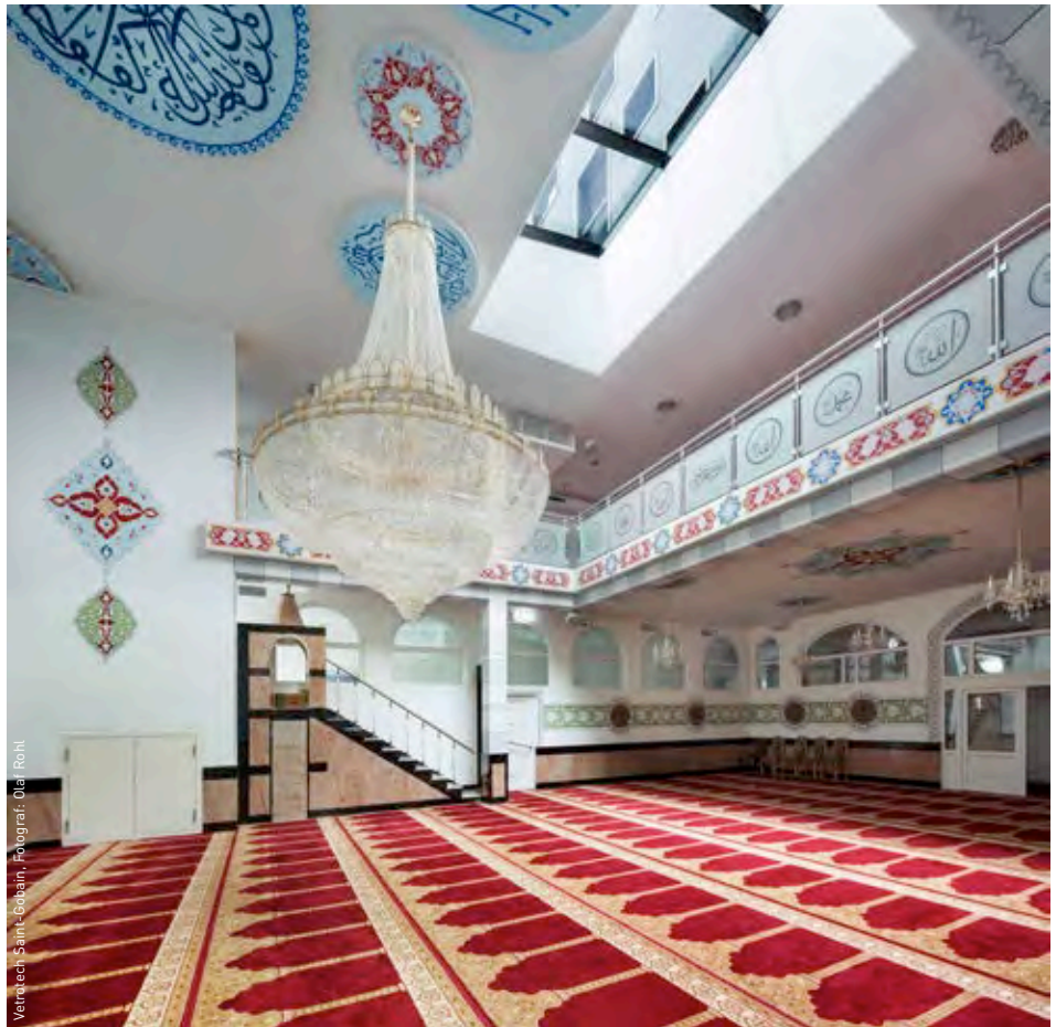
Im Gebetsraum der Muslime kam die Brandschutzverglasung «Contraflam 30» zum Einsatz.
