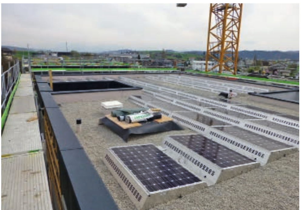
Auf dem Flachdach wurde eine Fotovoltaikanlage von der BE Netz AG installiert.
