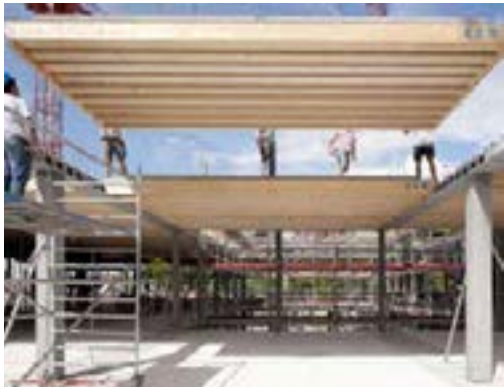
1 Millimetergenau passt das Verbundelement in die Stützenriegelkonstruktion. | L'élément hybride s'inscrit au millimètre près dans la construction piliers-traverses
