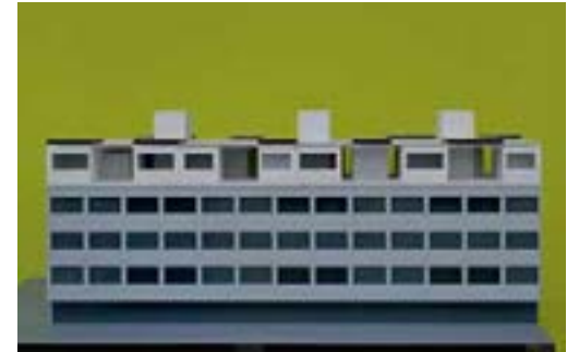
4 Zu den aufgesetzten Raummodulen gesellen sich Wand- und Deckenelemente. | Des éléments de mur et de plafond s'ajoutent aux modules spatiaux superposés.
