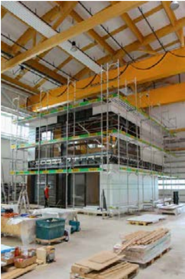
Renggli baute das Moduleinfamilienhaus testhalber in der Halle auf. | Renggli a fait un montage test en atelier de la maison individuelle. Foto | Photo: Renggli
