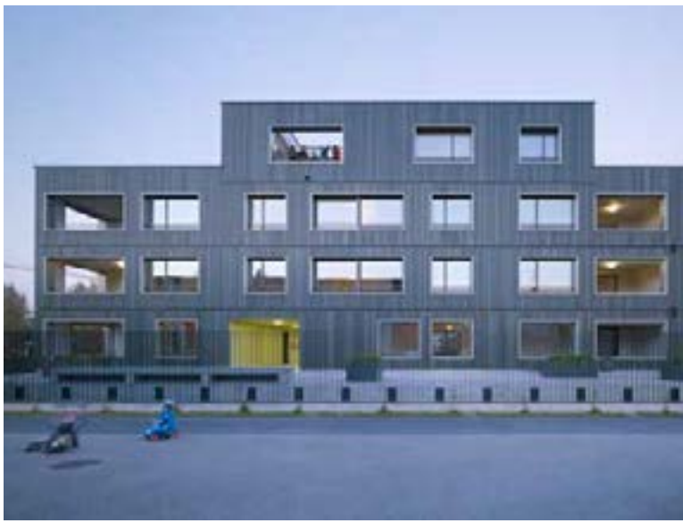
3 Das Mehrfamilienhaus in Nebikon LU basiert auf einem Raummodul. | La maison plurifamiliale à Nebikon est basée sur un module spatial.
