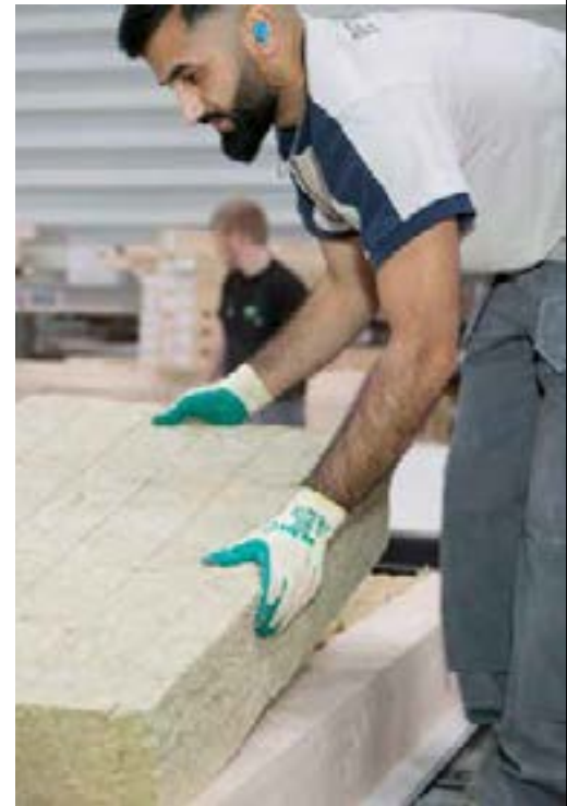
Ein Arbeiter legt die Dämmung in die Wandkonstruktion. | Un ouvrier pose l'isolation dans la construction du mur.
