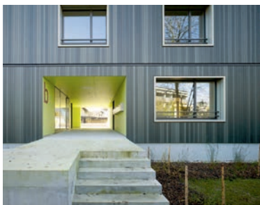
Das Hochparterre schützt das Haus vor Hochwasser.
