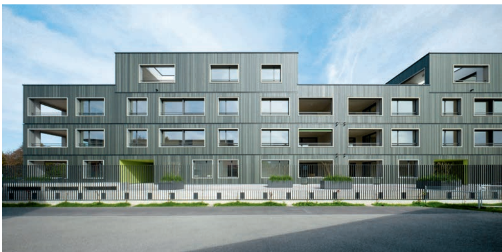
Die horizontalen Linien zwischen den Geschossen deuten an: Dieses Haus besteht aus vorfabrizierten Elementen.
