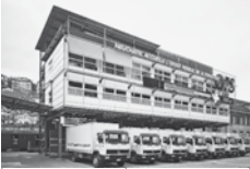
Bürobau, Neuenburg/CH Bauart Architekten und Planer, CH
