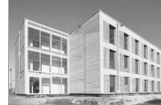
ICS Kalbach-Riedberg, Frankfurt am Main/D NKBAK, Frankfurt am Main/D
