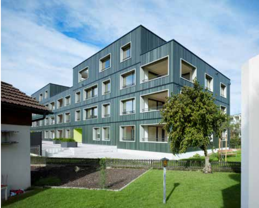
Swisswoodhouse ist ein von Bauart und Renggli AG konzipiertes Holzbausystem, das den Anforderungen an die 2000-Watt-Gesellschaft entspricht. Das erste Swisswoodhouse entstand in Nebikon (LU). Das gesamte Gebäude wurde im Werk vorgefertigt und vor Ort in nur drei Wochen montiert.
