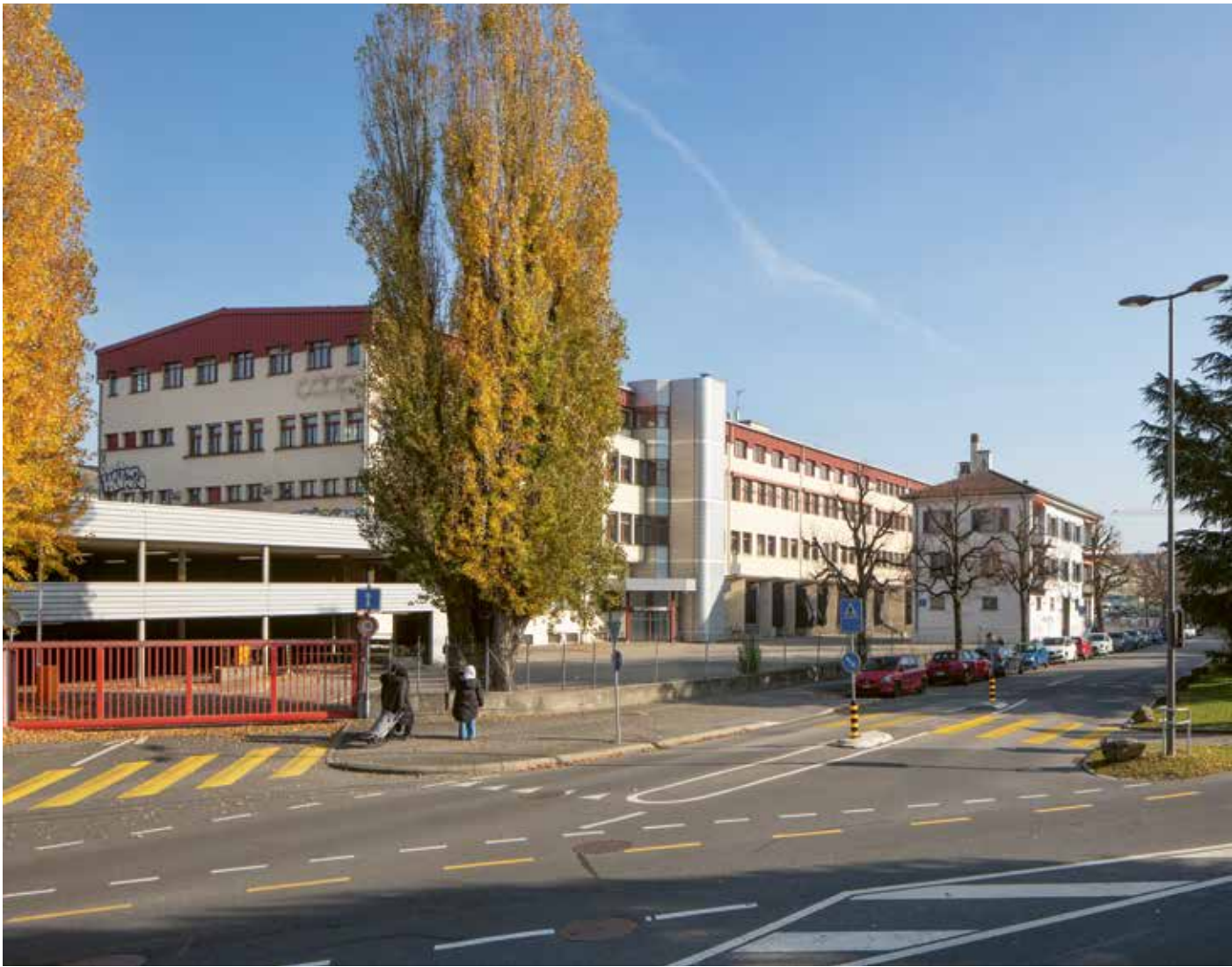
B Le centre de logistique avant sa transformation (© Bauart / Yves André)
