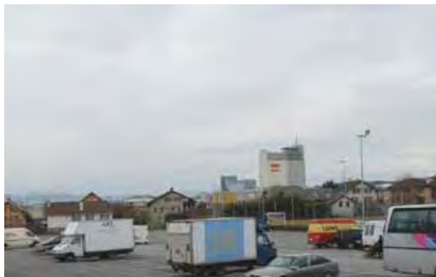
Silos existants à Renens
