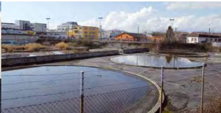
Fondations des anciens dépôts pétroliers
